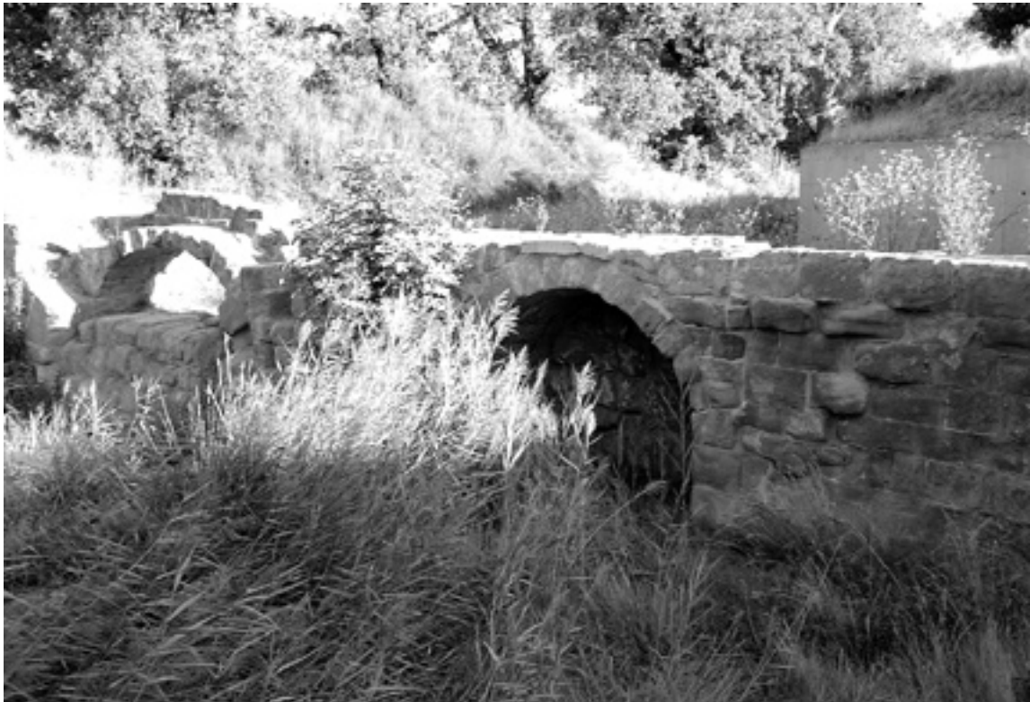
Puente acueducto en Quicena.
