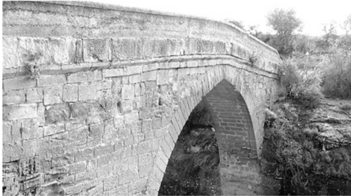
Puente sobre el Guatizalema en Sipán.
