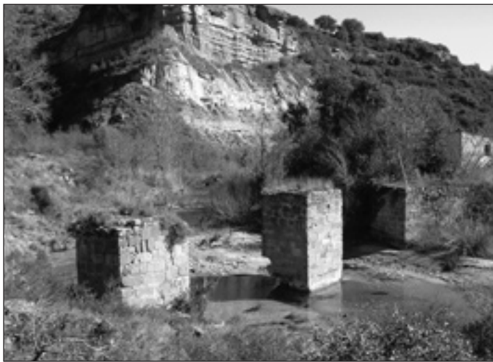
Estribos y pilares en el río
