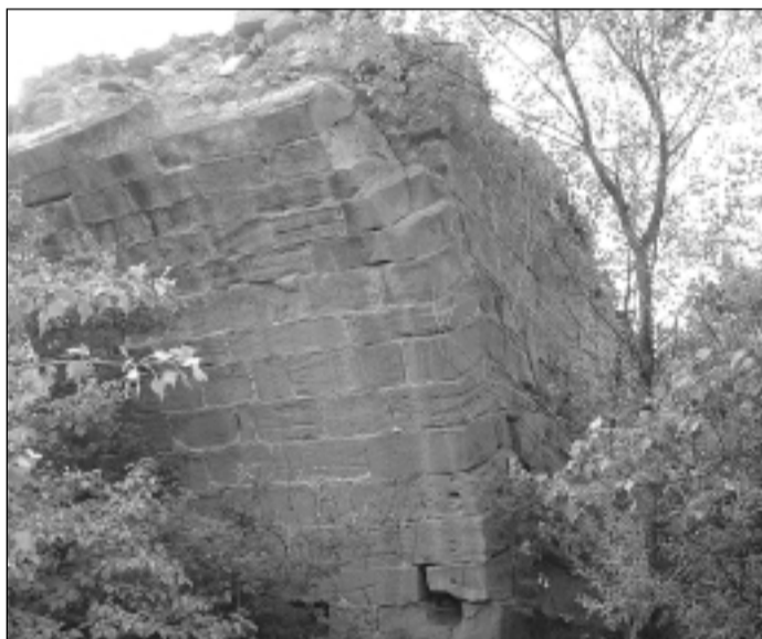
Puente de Las Aguas
