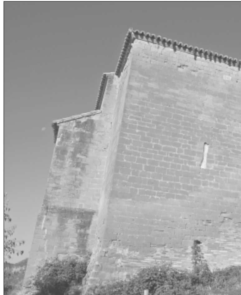
Exterior del ábside de San Nicolás
